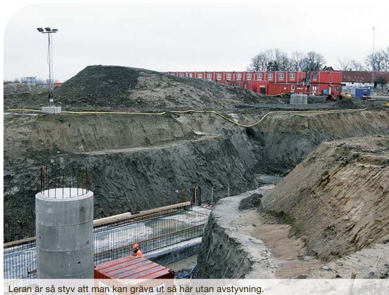
Leran är så styv att man kan gräva ut så här utan avstyvning.
